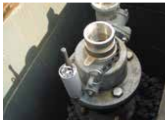
消火栓へのロガー設置
