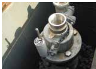
消火栓へのロガー設置
